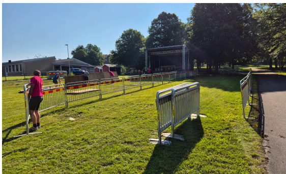
Arenabyggnation inför Bagheerastafetten, Ludvig Danfors bygger staket. Foto: Richard Lundstedt
